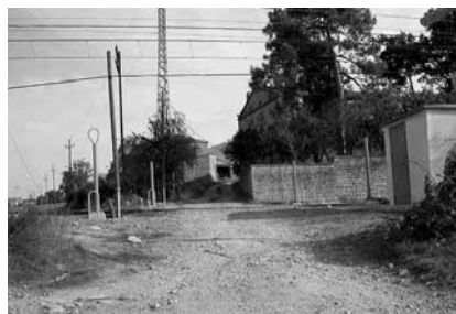
En l'actual arranjament dels rails entre Cervera i Calaf, també s'adequaran els passos a nivell.
